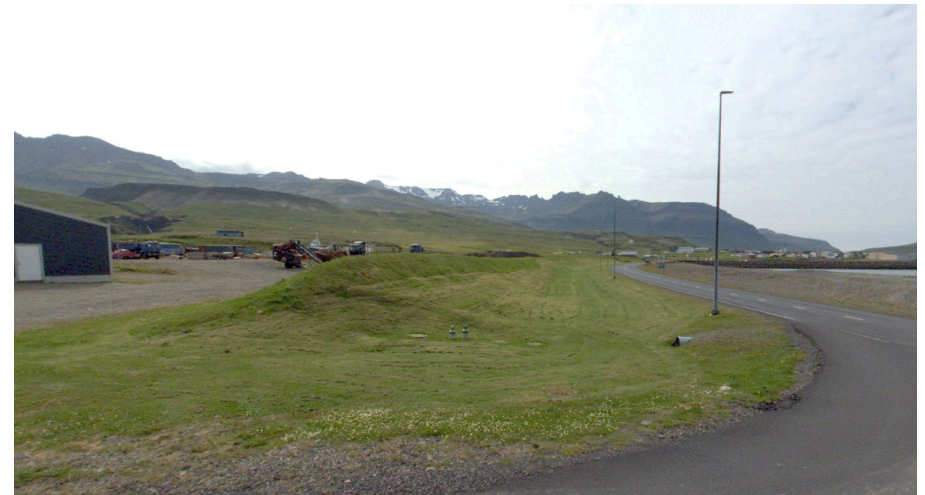
Mynd 2.10 sýnir stúta af hreinsistöð fyrir skólpl sem staðsett er norðan við Ártún 2. Ofanvatn safnast fyrir í þessari lægð í mikilli úrkomu og asahláku. Mynd af ja.is
