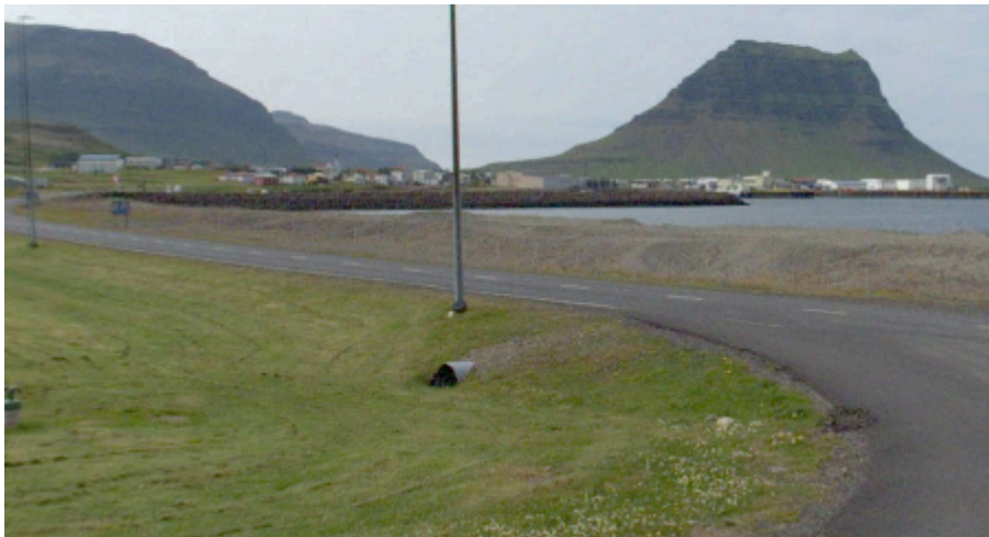
Mynd 5.5 sýnir hvar ofanvatni er safnað saman af austanverðu iðnaðarsvæðinu niður að Snæfellsnesvegi þar sem það rennur yfir og í gegnum síunarræmu að ræsi sem liggur undir Snæfellsnesveg og þaðan út í sjó. Mynd af www.ja.is desember 2024.
